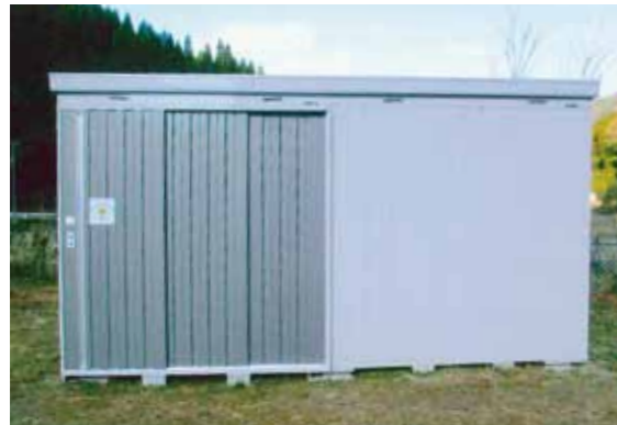
設置された物置。これらのコミュニティ活動備品は、宝くじ助成金を受けて整備されました
